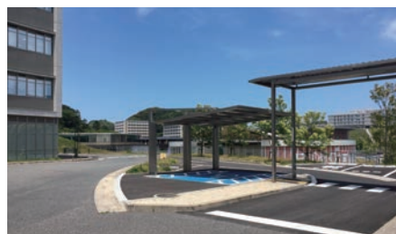
通り抜け式の新しい障害者用駐車場(伊都診療所)
